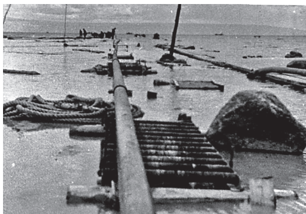
Первый в мире подводный трубопровод для перекачки нефтепродуктов был проложен в 1942 году в... блокадном Ленинграде. Фантастическая задумка и фантастическое воплощение. Трубопровод построили за 43 дня.
